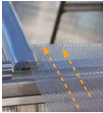
A táblákat egyszerűen rögzítették a kerületi profilokban.
