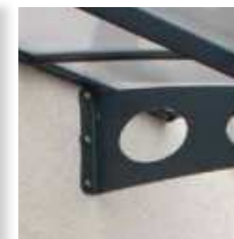
Horganyzott és lakozott acél merevítők
