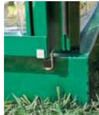
Mágneszáras a reteszelés a nyitott ajtónál.
